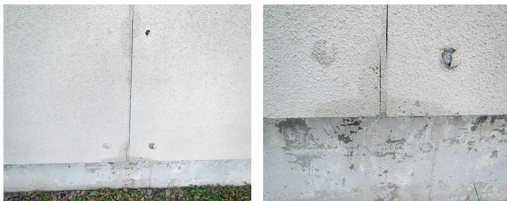
写真3 複合板間シーリングの切れからの水の浸入と滲出、ファスナー頭部における剥離（右は接写）
