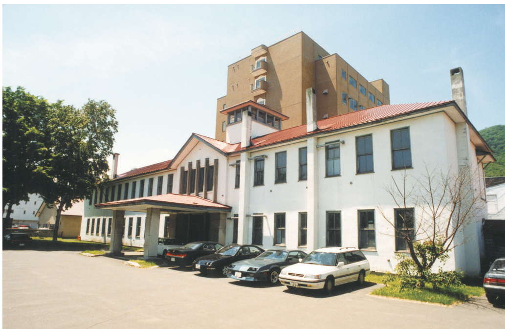
木造1号棟（当時，手前）と2号館（後ろ）
