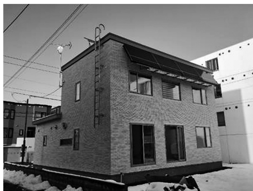
写真 1 南側、太陽熱集熱器
