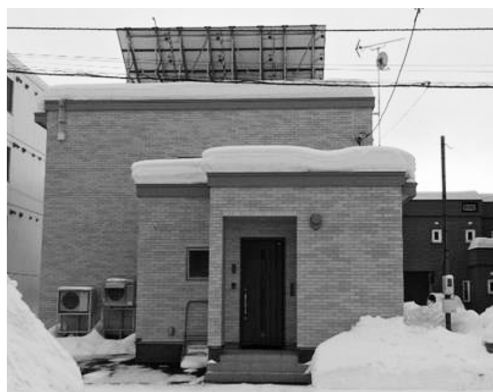
写真 2 北側、PV（太陽光発電）と駐車場
