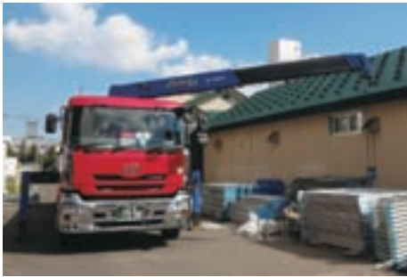
図 4 吊上げ作業による沈下量の増加（段階③）
