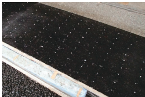
写真－2 凍結防止剤散布状況
