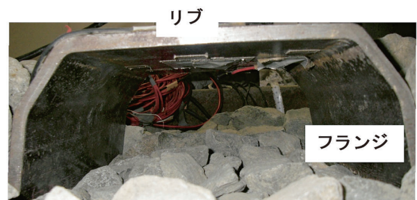
図-1 鉄まくらぎの断面
