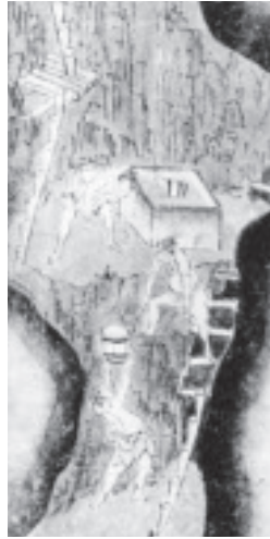
図-1 「手繰り」水替作業現場
