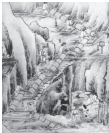
図-3 「水上輪」による水替作業現場
