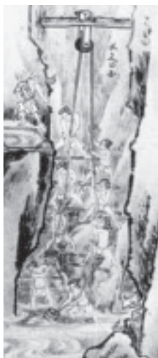
図-2 「車引き」水替作業現場
