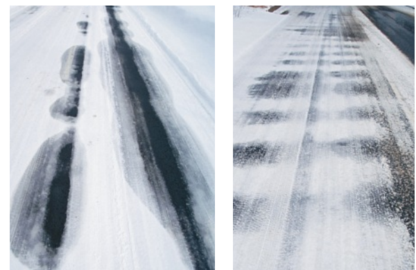
写真-7 圧雪路面露出状況（左：縦断露出 右：横断露出）
