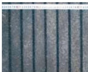
写真－1 G-9の舗装表面
